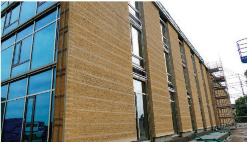
6 + 7 Einzel aufeinander geschichtete Lehmblöcke bilden die Fassade.
