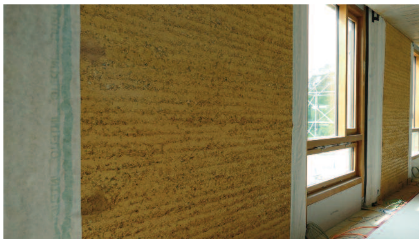
5 Die Stampflehm-schicht von innen: Hier wurde eine Wandheizung integriert, was bisher einzigartig ist. Die Innenwände sind unverputzt, so dass die Struktur der Lehmblöcke sichtbar ist.
