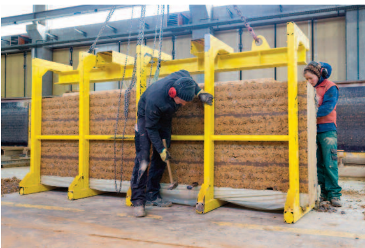
2 Die Lehmblöcke wurden mit einer professionellen Serienproduktion von Erden Lehmbau GmbH hergestellt. Zum ersten Mal wurde ein zweischaliges Stampflehmfertigteile mit innenliegender Kerndämmung eingesetzt. Foto: Dorsaz/Lehm Ton Erde
